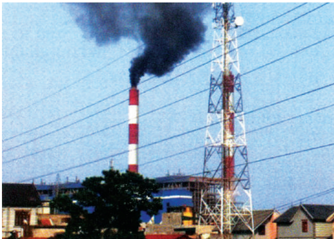
Khói nhà máy tại Ưông Bí, Quảng Ninh Nguồn: www.halong.gov.vn
